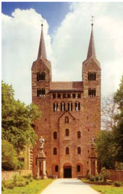
Figura 1. Fachada del «cuerpo occidental» del Monasterio de Corvey (822-848).
